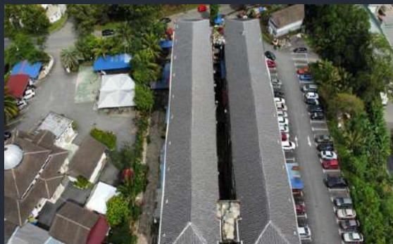
BUMBUNG BLOK C DAMAI COURT
